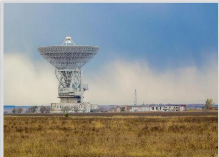
卫星通信基础设施建设稳步推进
